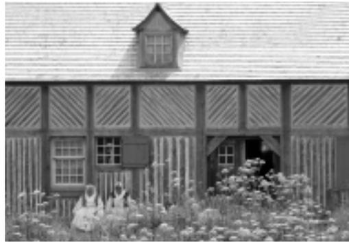
IMAGE 55. Bâtiment à ossature de bois avec remplissage de piquets
